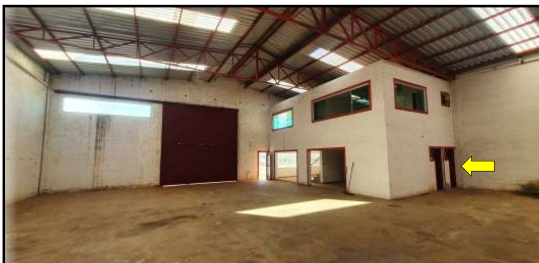
Vista geral interna
