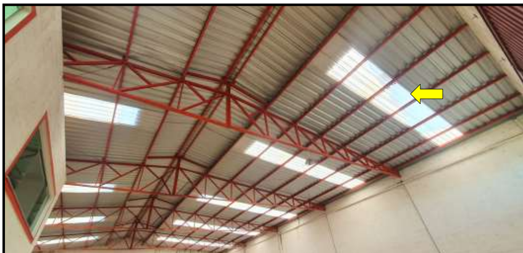
Detalhe da cobertura metálica
